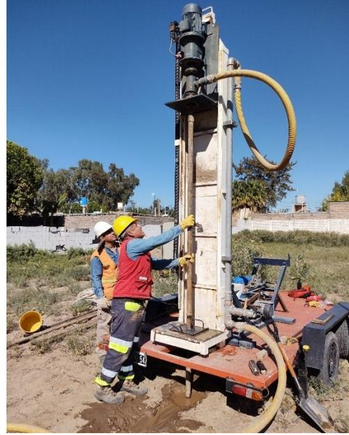
Figura 6: Ejecución de sondaje SO\_01.
